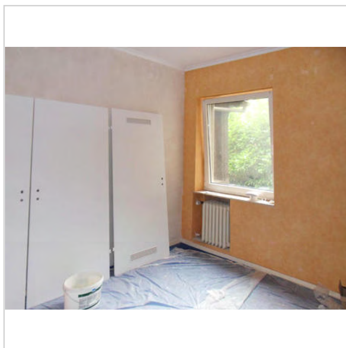
Schlafzimmer beim Umbau
