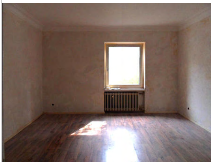
Wohnzimmer beim Umbau
